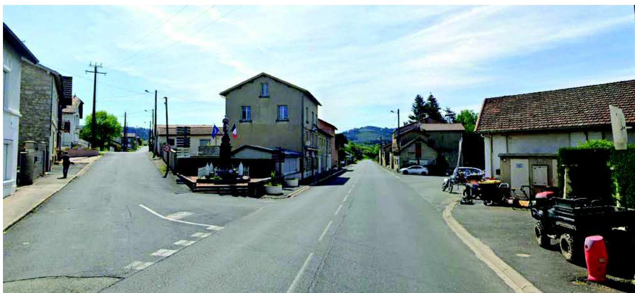
Vue actuelle de la Route de Lyon au croisement avec la Rue du Stade
