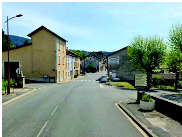
Vue actuelle du croisement entre la Route de Clermont et la Rue du Seitol
