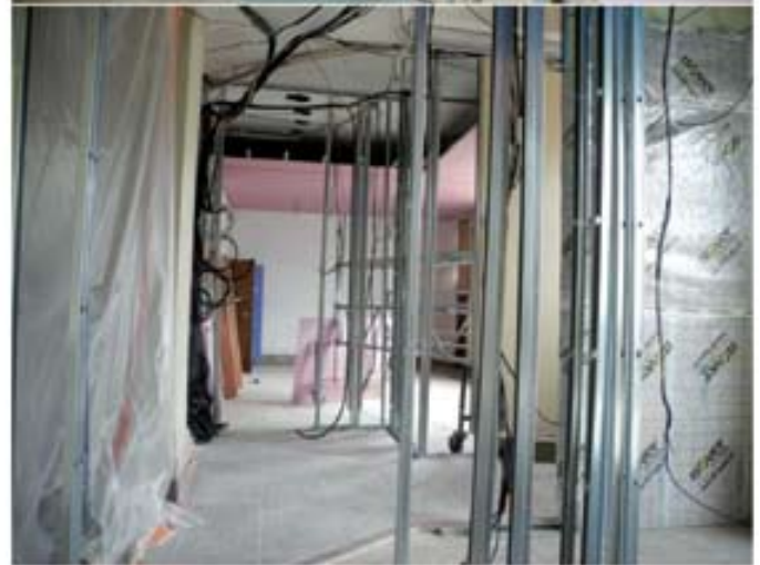
Vues des travaux
