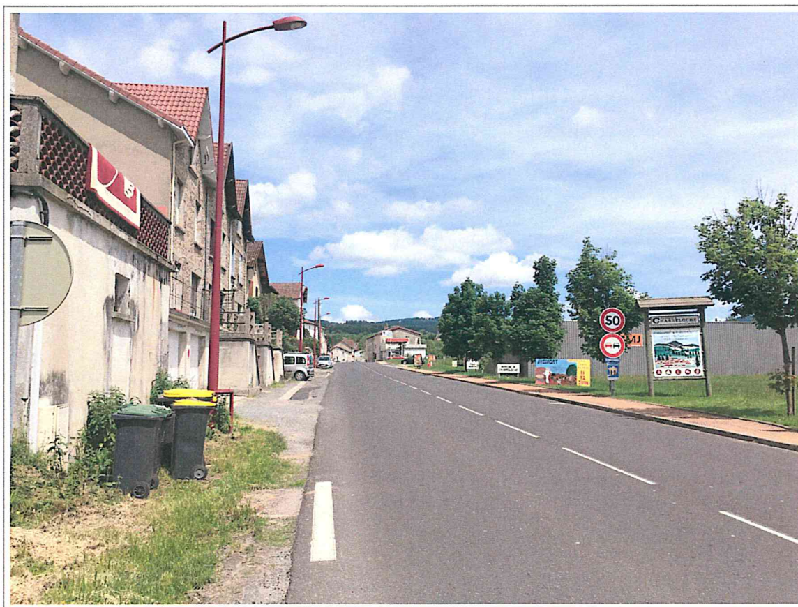
Vision générale de la traverse du bourg de Chabreloche en bordure de la RD 2089, avec le quartier commercial en cours de développement
