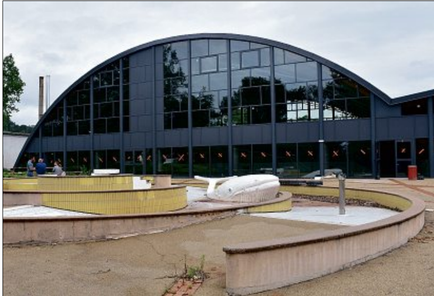
CHANTIER. Si la construction du nouveau bâtiment d'accueil et la rénovation des bassins seront terminées dans les prochaines semaines, les espaces extérieurs feront eux l'objet d'une autre phase de travaux livrés au printemps 2020.
