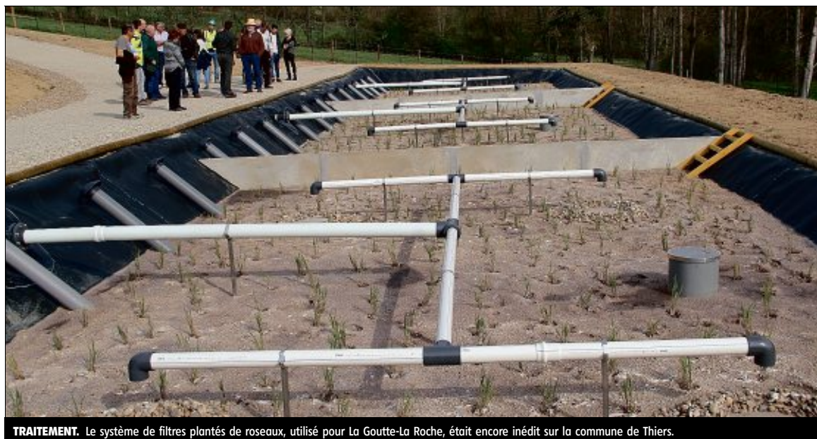
TRAITEMENT. Le système de filtres plantés de roseaux, utilisé pour La Goutte-La Roche, était encore inédit sur la commune de Thiers.
